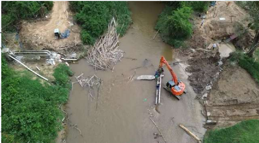
CONSTRUCCIÓN DE VIADUCTO SECTOR BARRIO LIBERTA DEL MUNICIPIO DE PITALITO
