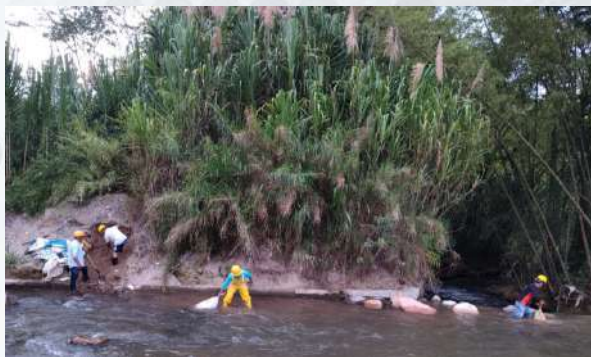
MANTENIMIENTO LIMPIEZA ZONA DE CAPTACION
