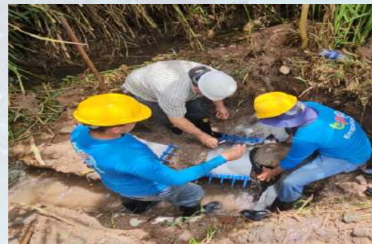
REPARACION RED DE CONDUCCION
