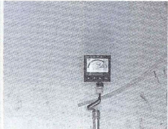
Fotografía No. 6 y 7 . Macro medidores ubicados en la salida de los desarenadores, los cuales debido a las fuertes lluvias presentadas en la zona, se descalibraron y no estaban en buen funcionamiento
