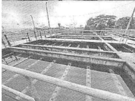
Fotografía No. 10 – 13. Proceso de sedimentación y filtración en la planta
