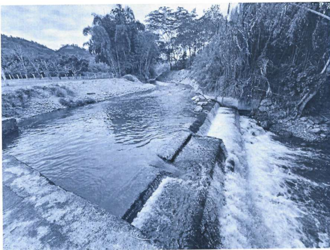
Ilustración 13 Rejilla de captación existente en la captación Río Guachicos
