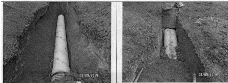
Ilustración 31. Instalación de tubería Fuente: Informe final de interventoría- Contrato 084 de 2014 EMPITALITO ESP
