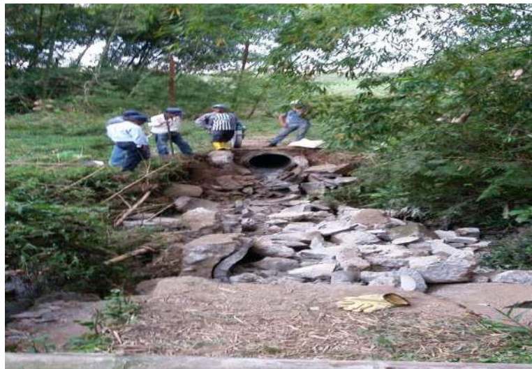
Ilustración 34. Demolición de la estructura afectada Fuente: Informe de vertimientos, Unidad Operativa 2015
