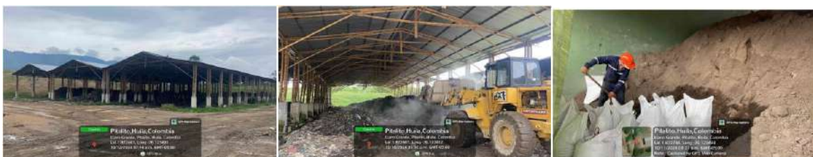
Ilustración 20 Planta de tratamiento Biorgánicos del Sur Fuente: Biorgánicos de Sur
