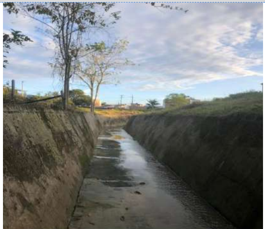
Limpieza de Zanjón de los Tiestos
