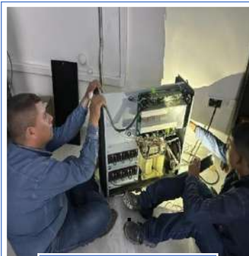
Cambio de baterías UPS centro de datos
