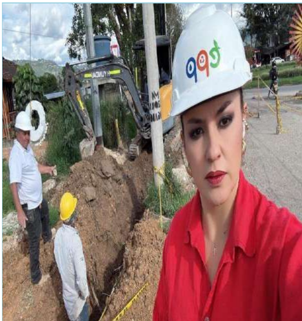
Visitas de seguimiento contratistas de obra
