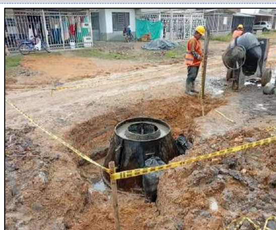
Construcción de Pozos en concreto de 4000 PSI (Cono)
