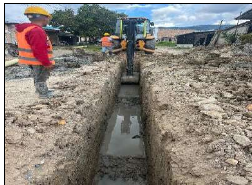
Excavación Mecánica e Instalación de Tubería en PVC (Red Principal).
