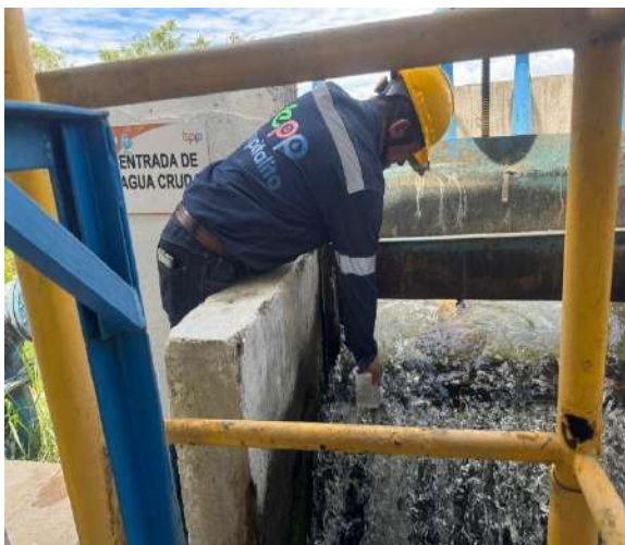
Inspecciones y capacitaciones correcto uso de EPP
