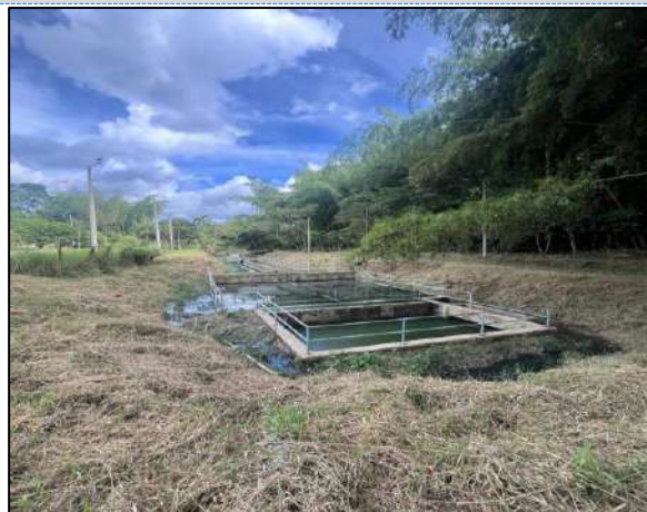
Limpieza de PTAR
