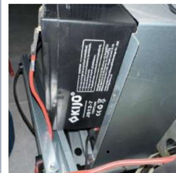
Cambio de baterías UPS centro de datos
