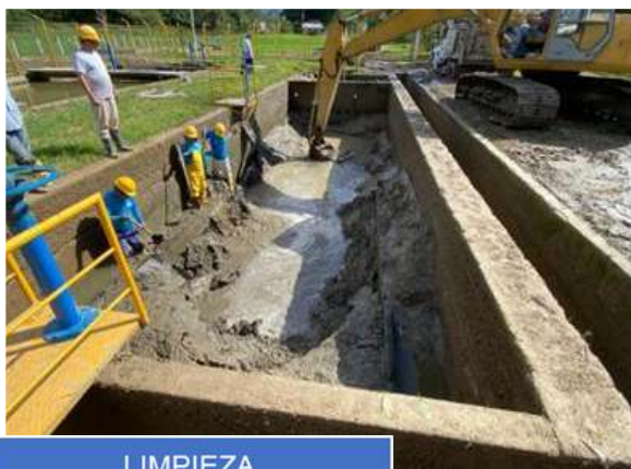
LIMPIEZA DESARENADORES DE 12"
