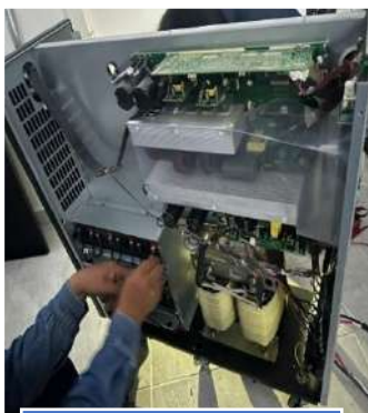
Cambio de baterías UPS centro de datos
