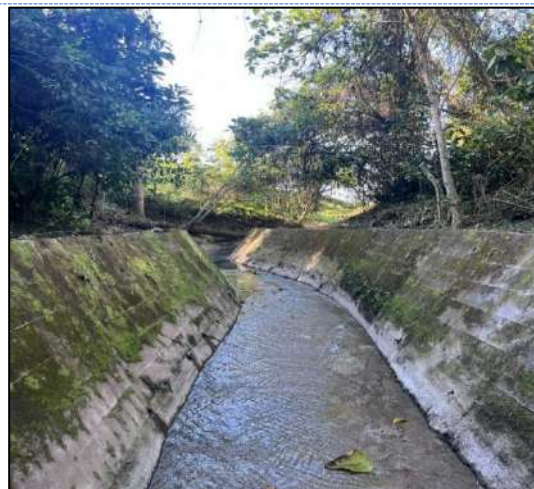
Limpieza de Zanjón del Burro
