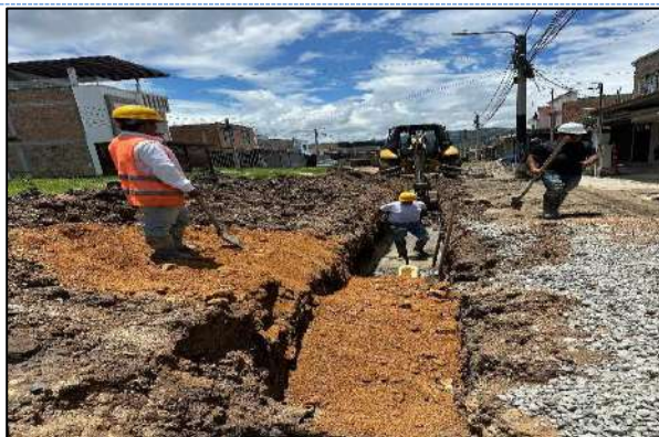
Relleno en Material de Recebo
