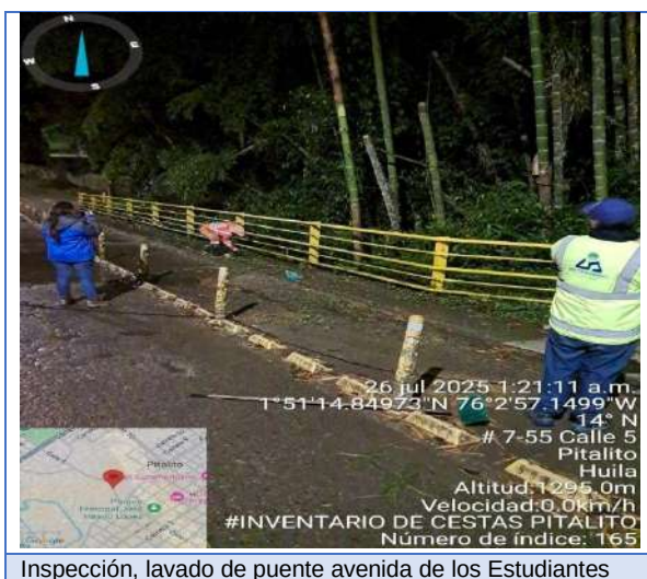
Inspección, lavado de puente avenida de los Estudiantes
