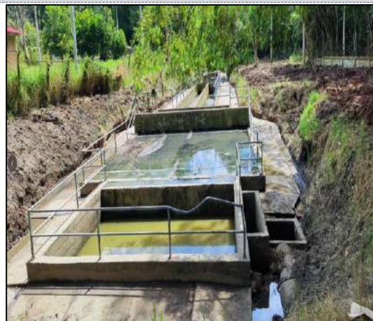
Limpieza de PTAR
