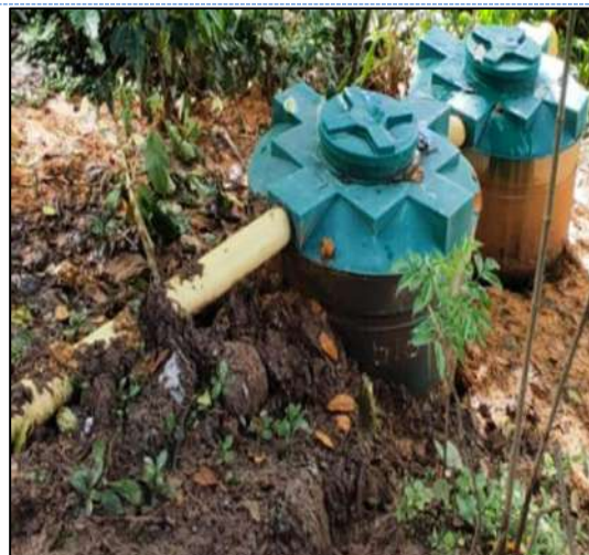
Instalación de Sistemas Sépticos
