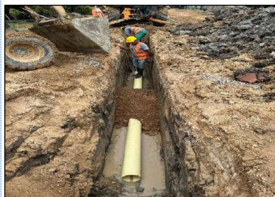
Excavación Mecánica e Instalación de Tubería en PVC (Red Principal).
