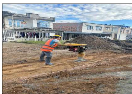
Compactación del Material
