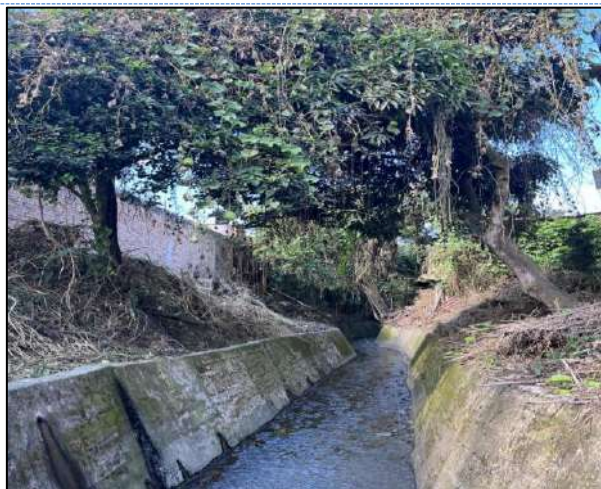
Limpieza de Zanjón del Burro
