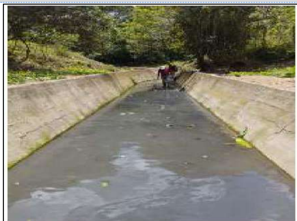
Limpieza de Zanjón de los Tiestos
