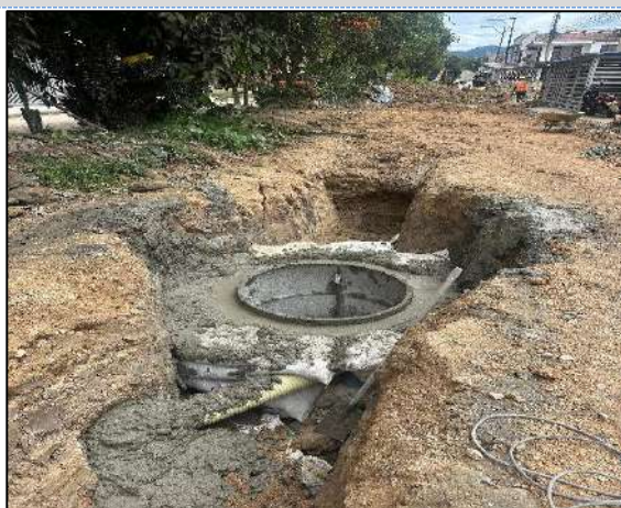
Construcción de Pozos en concreto de 4000 PSI (Cilindro)
