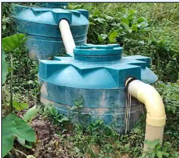
Instalación de Sistemas Sépticos
