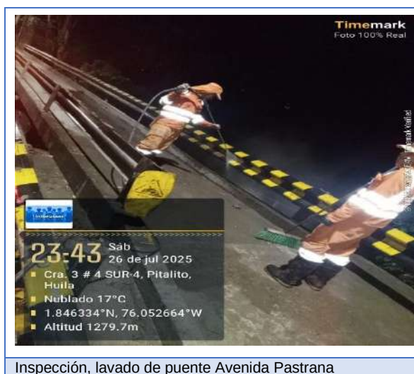
Inspección, lavado de puente Avenida Pastrana
