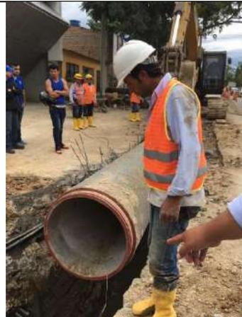
Instalación tubería 30" CCP
