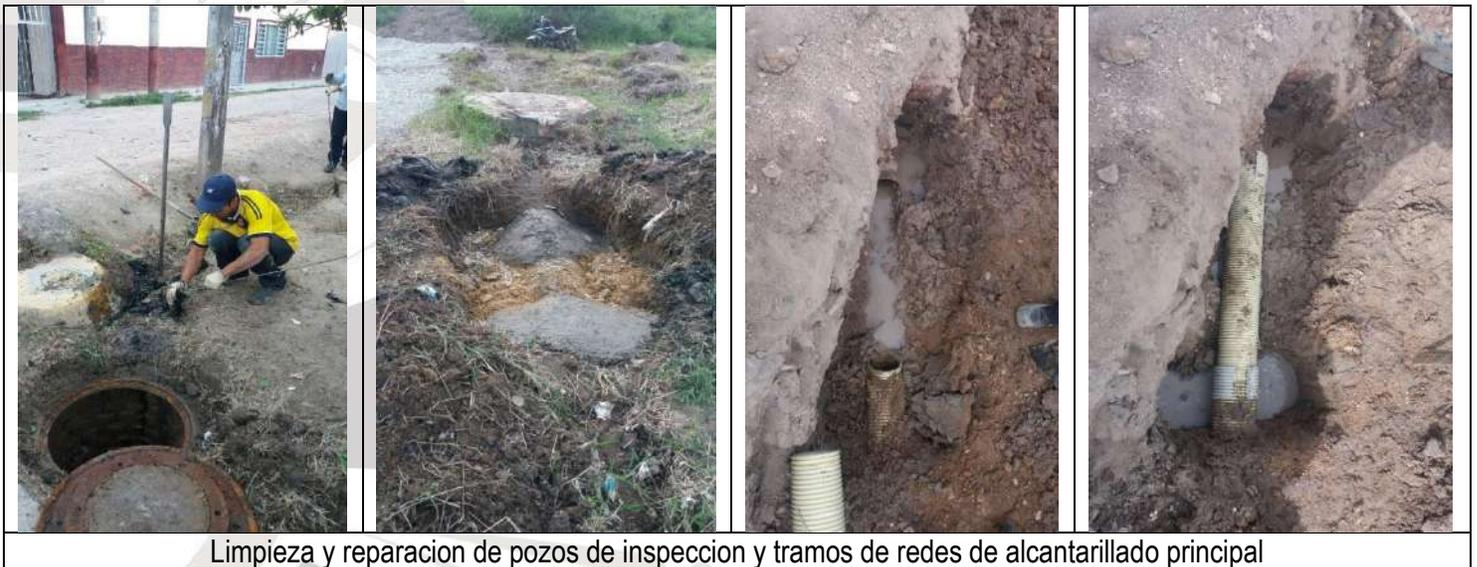
Limpieza y reparación de pozos de inspección y tramos de redes de alcantarillado principal
