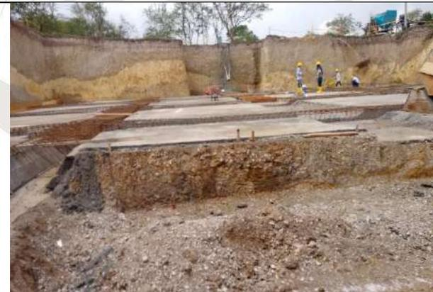
Excavación y solado tanques de almacenamiento
