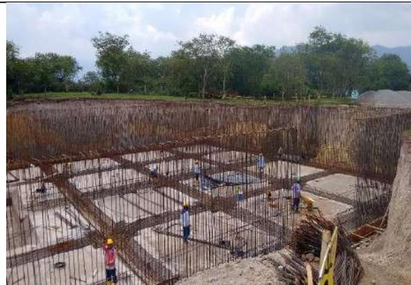
Izado acero de refuerzo tanque de almacenamiento
