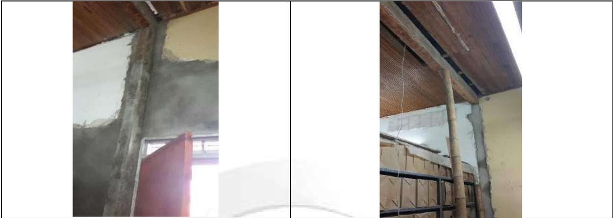
Fundición de viga y columnas en concreto a 3000PSI.
