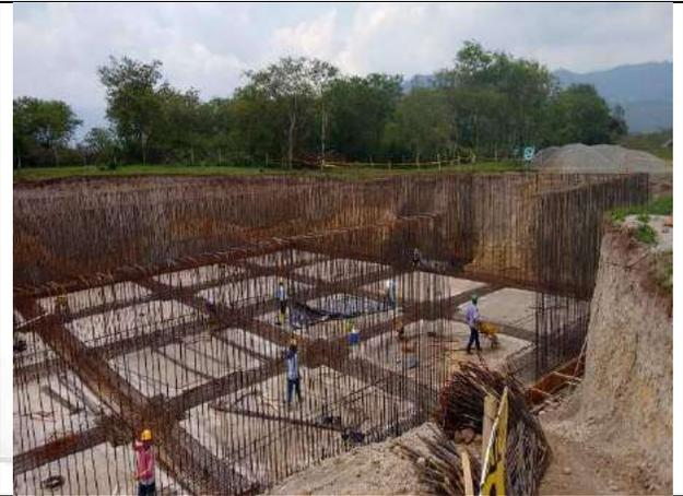
Solados e instalación acero cimentación y muros tanque almacenamiento
