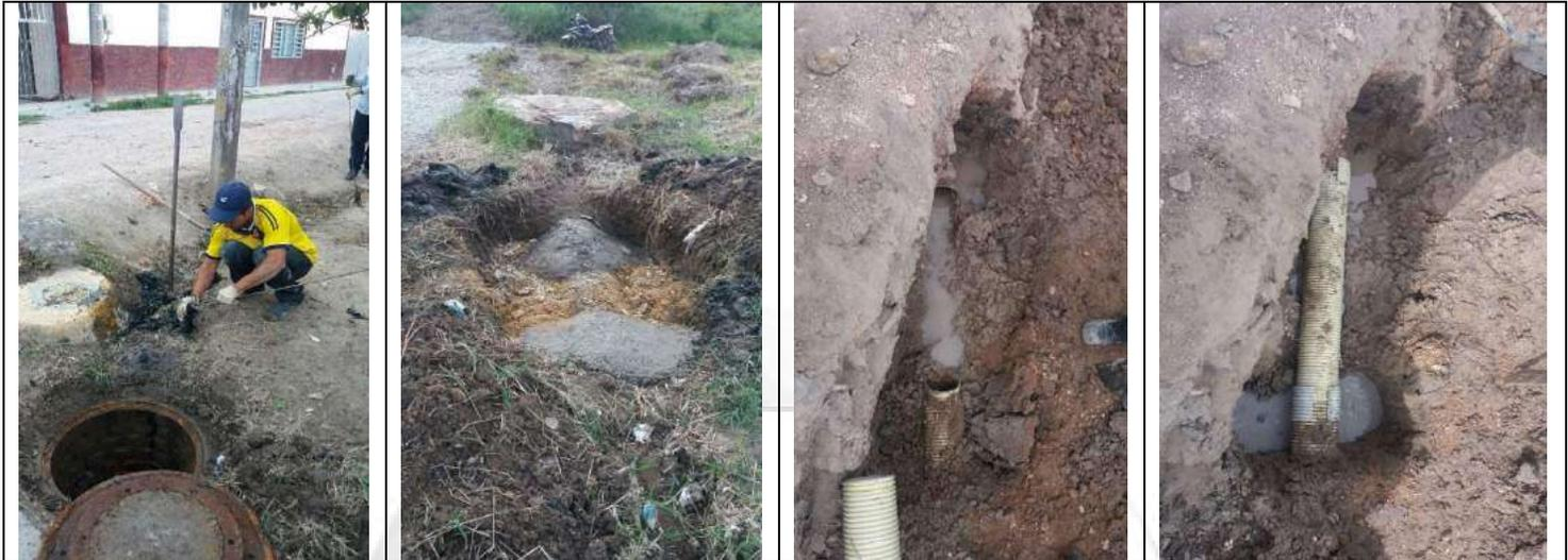
Limpeza y reparacion de pozos de inspeccion y tramos de redes de alcantarillado principal
