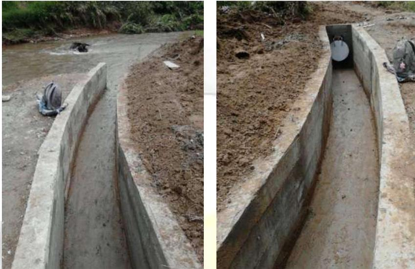
Se deben seguir construyendo este tipo de estructuras en los sectores en donde el sistema de alcantarillado combinado, tenga colapsos en los tiempos de grandes lluvias, para aliviar los excesos de las aguas lluvias y evitar las inundaciones en sectores particulares del Municipio de Pitalito.
