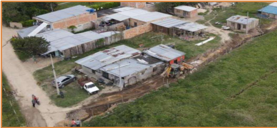
Imagen 33: Durante las Construcción sistema de acueducto bajo solarte
