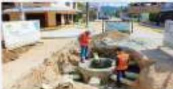
Se presentó un hundimiento de la estructura vial en concreto rígido sobre la Carrera 2 entre las Calles 4 y 5, debido a la excavación generada por una fuga en la red de alcantarillado por un de 2 pulgadas que genera el poco de tracción en el barrio Los Lagos.
